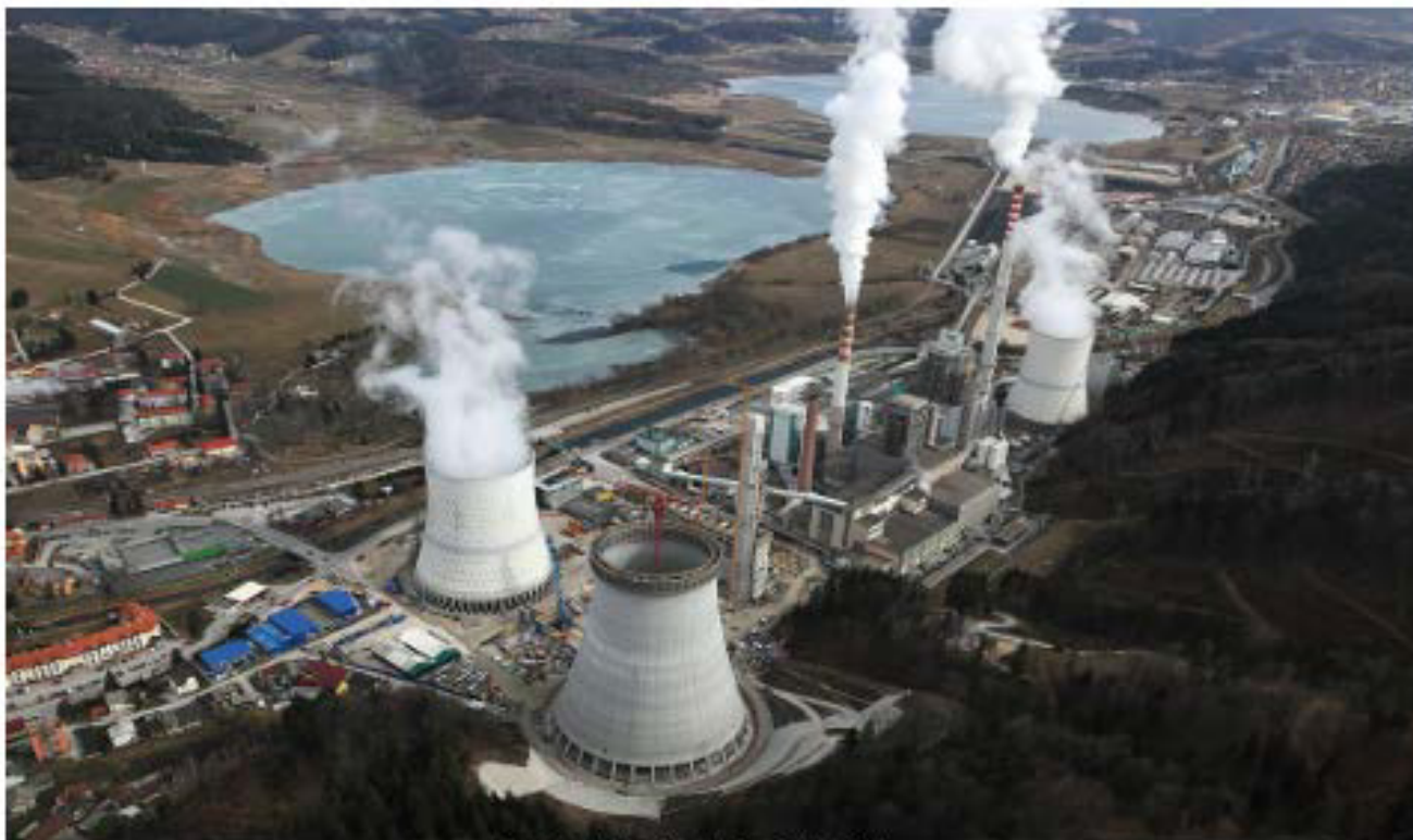
Termocentrale di Sostanj - Fonte: Delo
